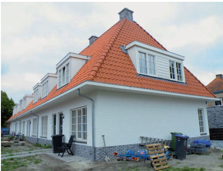
Voormalige arbeiderswoningen aan de Adelheidstraat, na de sloop en herbouw
