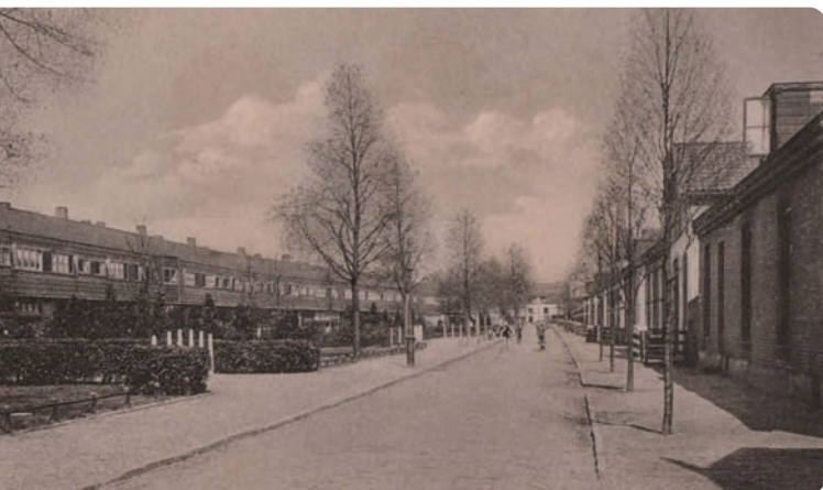
Het Oosterpad Rechts: Huizen aan het Eendrachtpark, met op de achtergrond de Paulusschool
