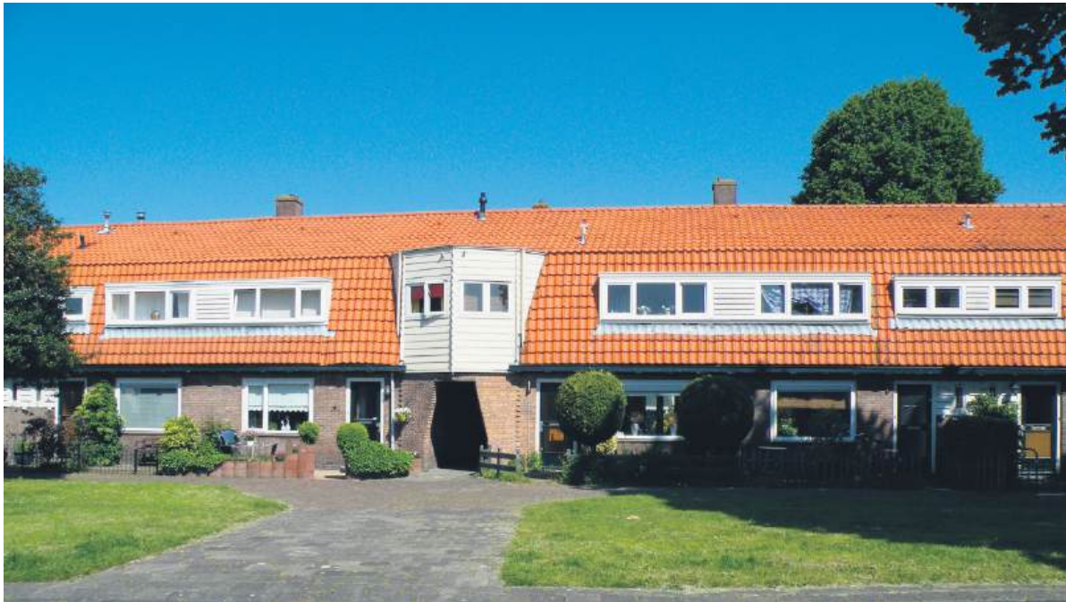
■ Deel van de lange rij woningen aan het Oosterpad. FOTO JAAP VAN HASSEL
