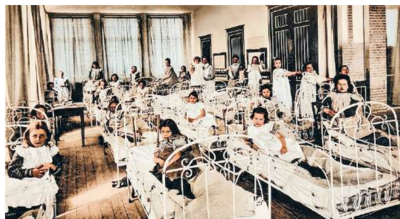
Koloniehuis „Kerdijk“ — EGMOND AAN ZEE. Slaapzaal. Inlichtingen over verpleging en het oprichten van afdelingen geeft A. C. BOS, Egmond aan Zee.
