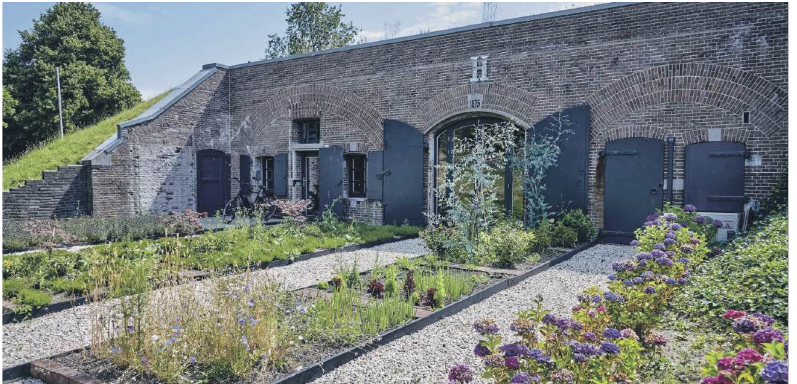
■ Fort H in Muiden na de restauratie
