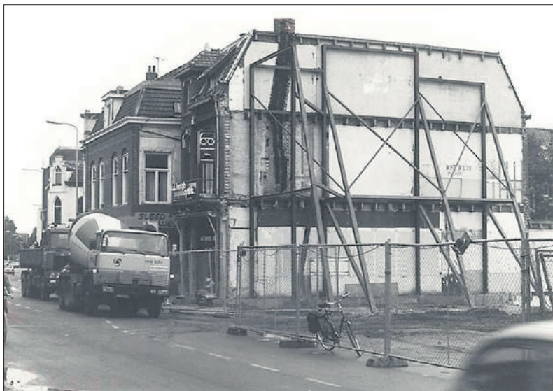
■ De zijkant van Brinklaan 81 na de sloop van 83 en 83A (1983).
